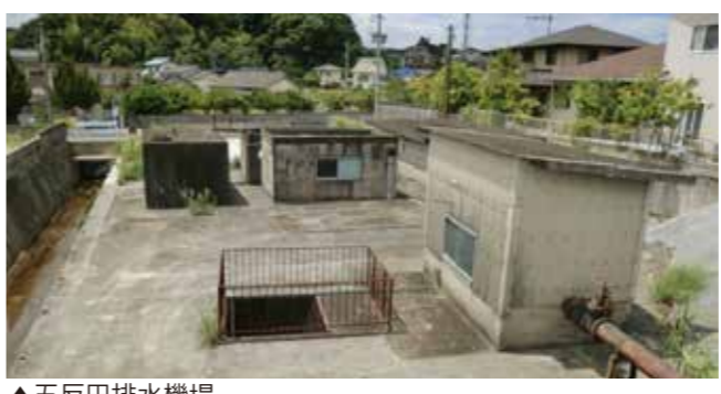
▲五反田排水機場
