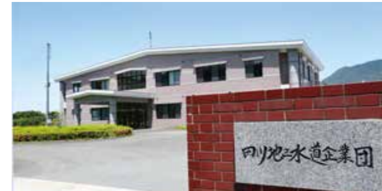
↑ 赤村にある水道企業団の事務所。構成団体から派遣される職員を中心に約15人が勤務し、併設された浄水場で田川地区に送られる水が浄化されています。
