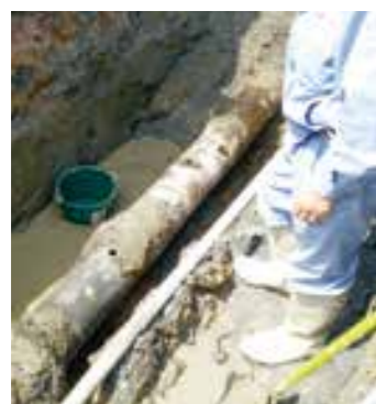
↑ 老朽化が進み漏水した銅管。状況に応じて最適な管への交換を進めています。
